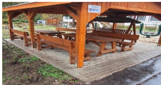
Pokládka zámkovej dlažby v altánku pri UD JAVOR a obohatenie priestoru dekoratívnymi prvkami
