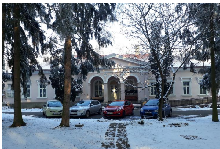
Budova Prónayovcov, hlavný vstup objektu po realizácii projektu (2018)
