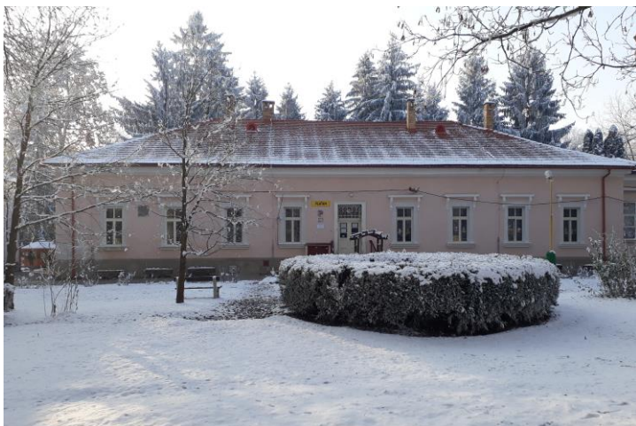
Budova Prónayovcov, severná strana objektu po realizácii projektu (2018)
